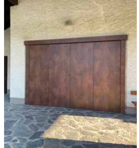
Sanierung und Instandhaltung der Aufbahnhalle Reisach
