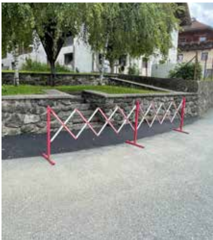
Asphaltierarbeiten beim Dorfplatz Grafendorf
