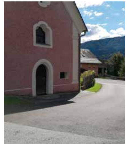
Asphaltierung Kirchenplatz Waidegg
