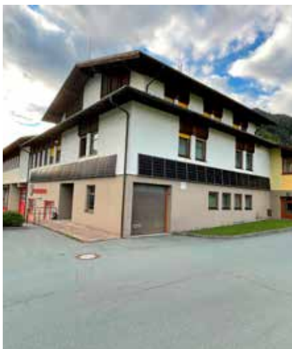
Installation der PV-Anlage am Gemeindeamt
