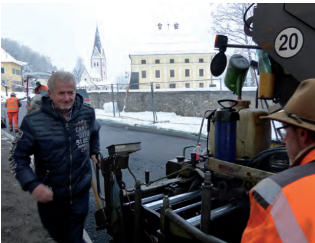
Vizebürgermeister Alois Spitzer bei den Asphaltierungsarbeiten am 4. Dezember 2020
