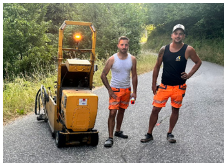
Straßensanierungen in der Gemeinde
