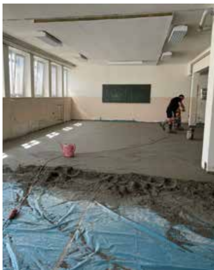
Sanierung der VS Gundersheim
