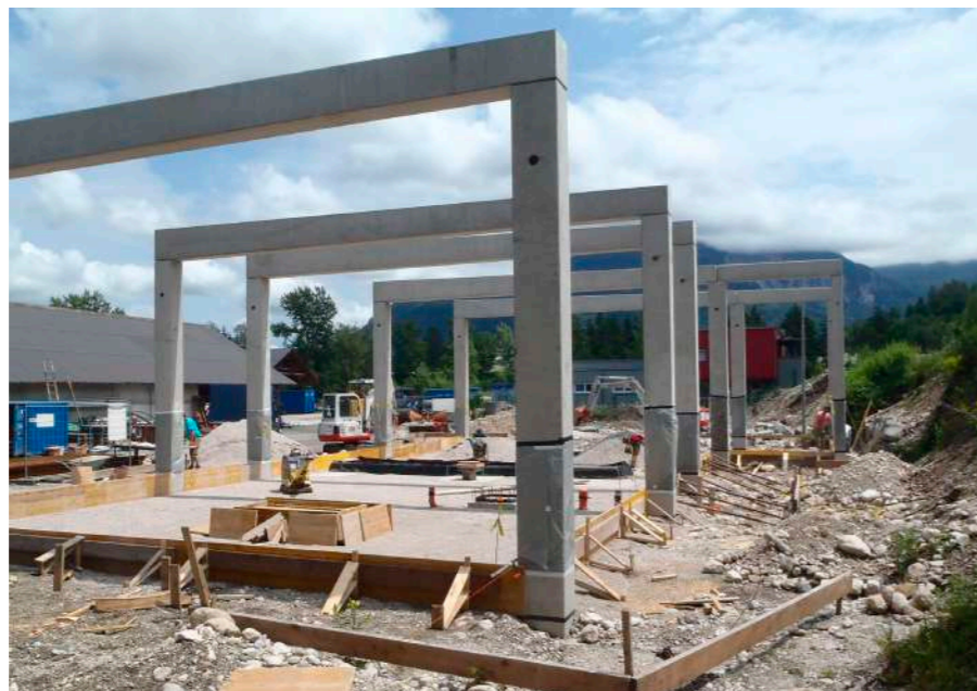
Zubau Bauhof Ferlach
