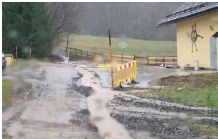
Überschwemmung bei einem Starkregenereignis während der Bauarbeiten der neuen Oberflächenentwässerungskanals.
