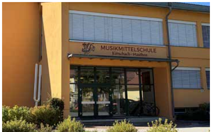
Die Nachmittagsbetreuung in der Mittelschule Kötschach-Mauthen konnte ausgebaut werden
