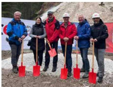
Spatenstich bei der Koschierquelle auf der Windischen Höhe am 15. April 2025 (v.l. GV Alfred Urban, Vbgm. Claudia Didl, Bgm. a. D. Georg Eder, Wasserwerkeleiter Fredi Gailberger, Vbgm. Dieter Nagelschmied und Bgm. Manuel Müller)
