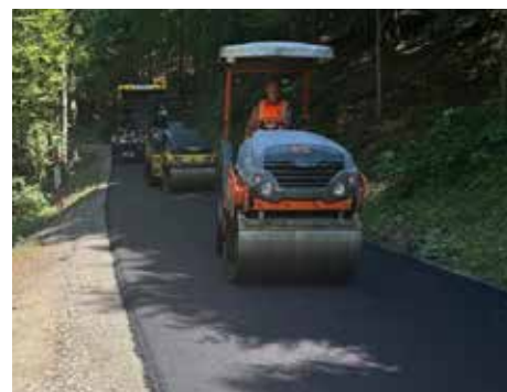
Unsere Gemeindestraßen laufend erneuern: Asphaltierungsarbeiten sorgen für sichere und verlässliche Verbindungen
