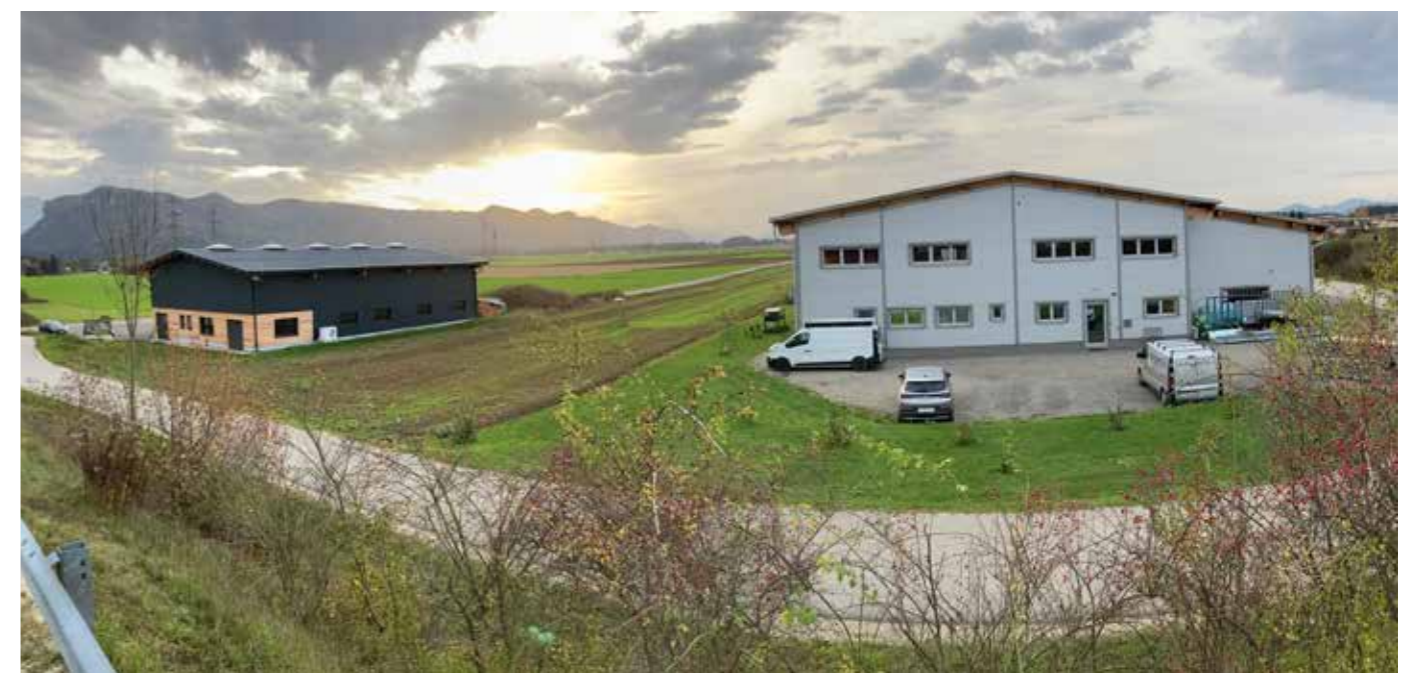
Der Gewerbestraße Süd wird ausgebaut
